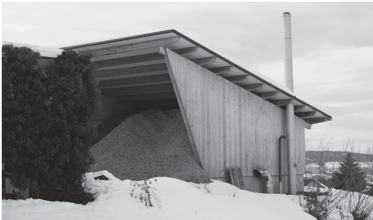
Das Holzschnitzlager hinter der Sennerei Bachtel
